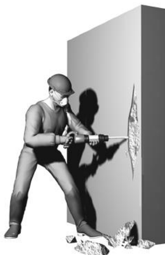
Figura 1 – Demolição superficial do concreto
