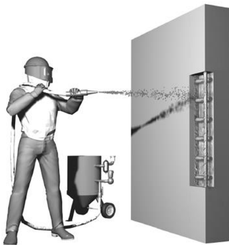
Figura 3 – Remoção da corrosão com jateamento abrasivo
